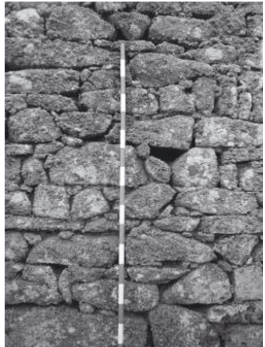
Figura 3: Pormenor de cachotaría en seco de granito
