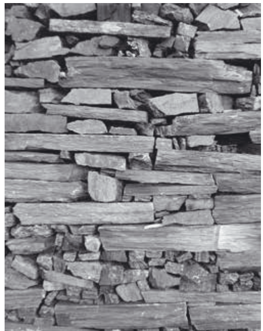
Figura 4: Pormenor de cachotaría en seco de xisto
