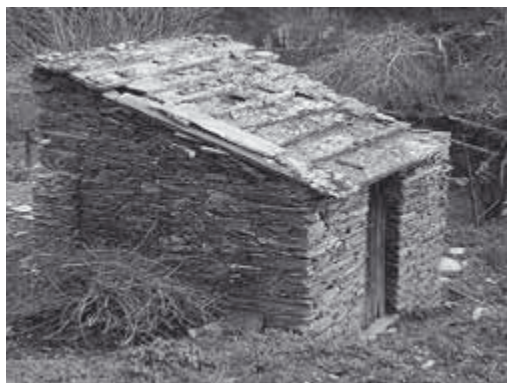
Figura 13: Mina privada de auga
